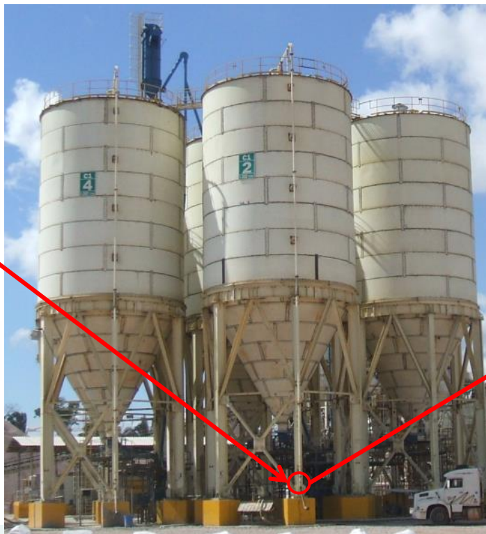
储罐安 装位置
